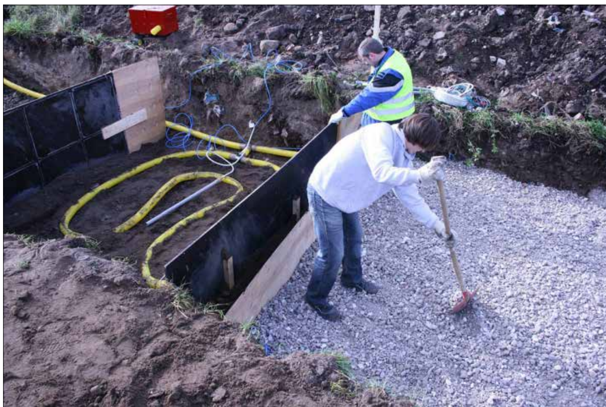
شکل ۶) نصب پاتل های تست ۱) کاملاً با مواد بازیافتی پر شده است) و پاتل تست ۲) خالی)
