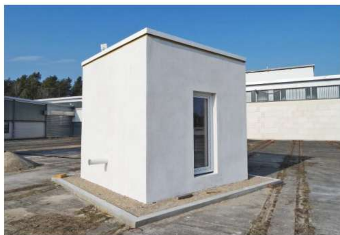
شکل یک: ساختمان تست که از بلوک های بتن هوادار اتوکلاو شده ساخته شده است.
