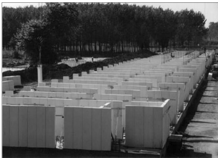
شکل (۳) ساختمان‌های پس از زلزله سرگو (Surgu)
