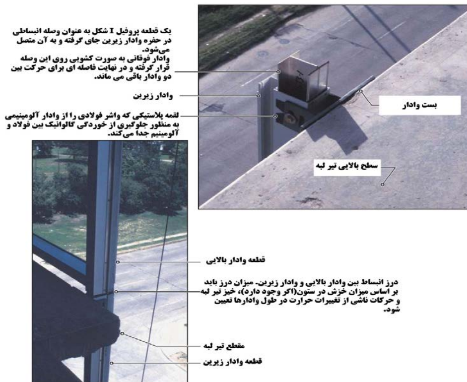
شکل ۹-۷- نمونه اتصال انبساطی بین دو قطعه وادار
