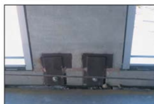
شکل ۸-۱۰- تیپ اتصالات دوخت به پشت که در سه جهت قابل تنظیم می‌باشند
