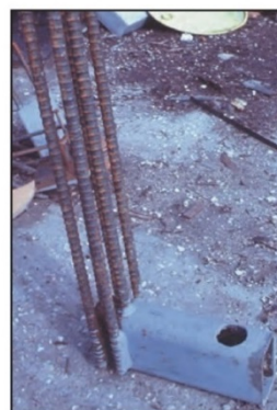
قوطلی فولادی جهت تکیه گاه اتکایی (ب)
