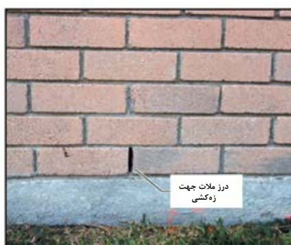
شکل ۵-۱۳- خالی گذاشتن درز ملات جهت زه‌کشی
